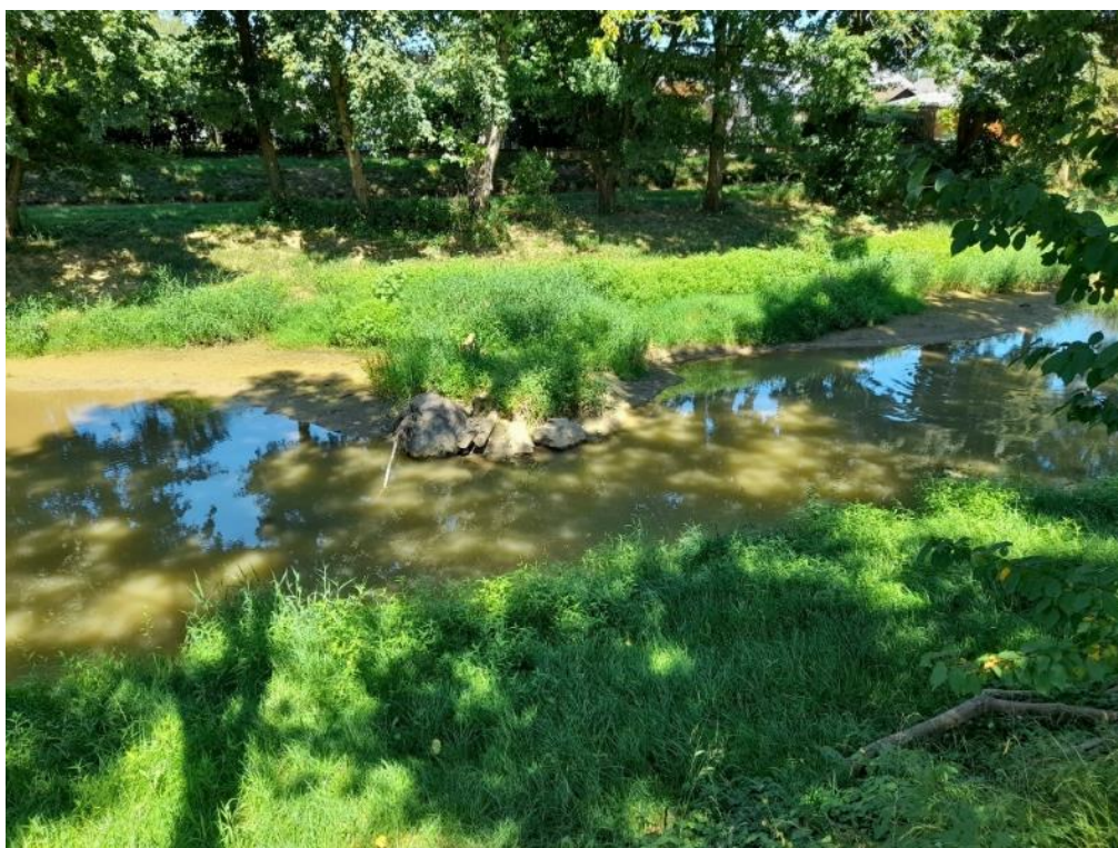
Slika 3: Sipina iz zemljine zaključena s skalami in lesenimi elementi zožuje prečni profil Abbildung 3: Eine mit Steinen und Holzelementen belegte Erddüne verengt das Querprofil
