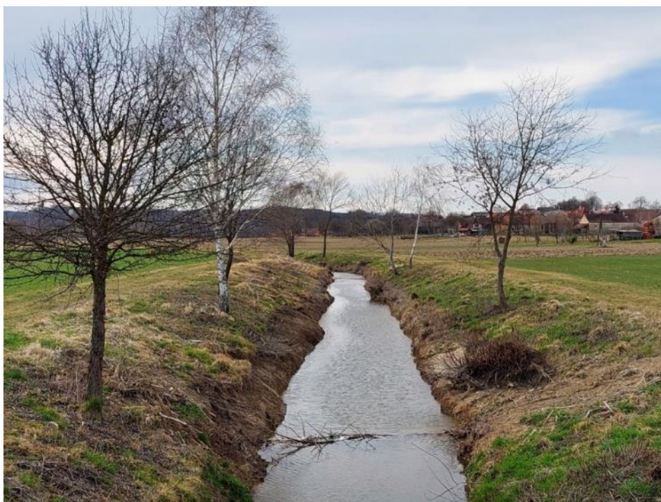
Slika 46: Stanje odseka v času terenskega ogleda, kjer so razvidne gole brežine (pogled gorvodno od mostu v bližini meje z Madžarsko)
