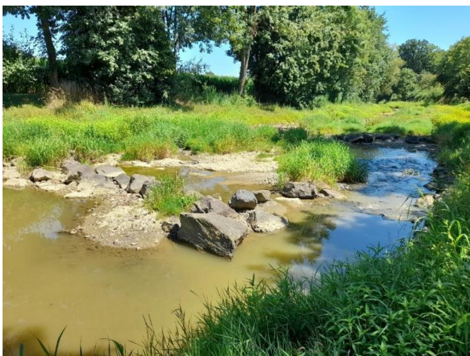
Slika 6: Naložene skale skozi večji del prečnega profila zožujejo pretočni profil. Za skalami nastajajo plitvi bazenčki, cela struktura pa ustvarja rokav rečnega zavoja. Ob zaključku skal, v sredini rokava, je umeščen talni prag
