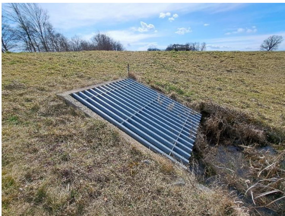
Slika 27: Iztok iz zadrževalnika dolvodno, zaščiten z rešetko proti zamašitvi
