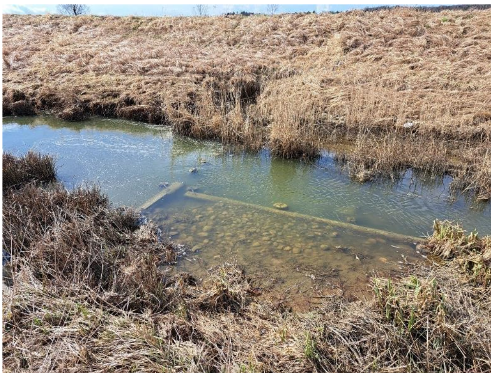
Slika 34: Dolvodna stran ustvarjenih mokrišč s potopljeno konstrukcijo
