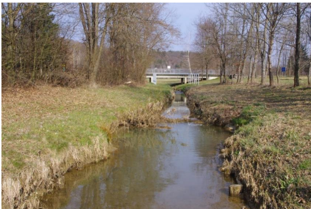
Slika 20: Pogled gorvodno na umetno obojestransko zajedo. Dolvodno od nje so vidni leseni piloti, uporabljeni za zavarovanje brežin
