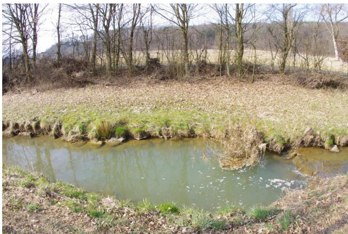
Slika 19: Obojestranska umetna zajeda pod talnim pragom na začetku ureditev gorvodno
