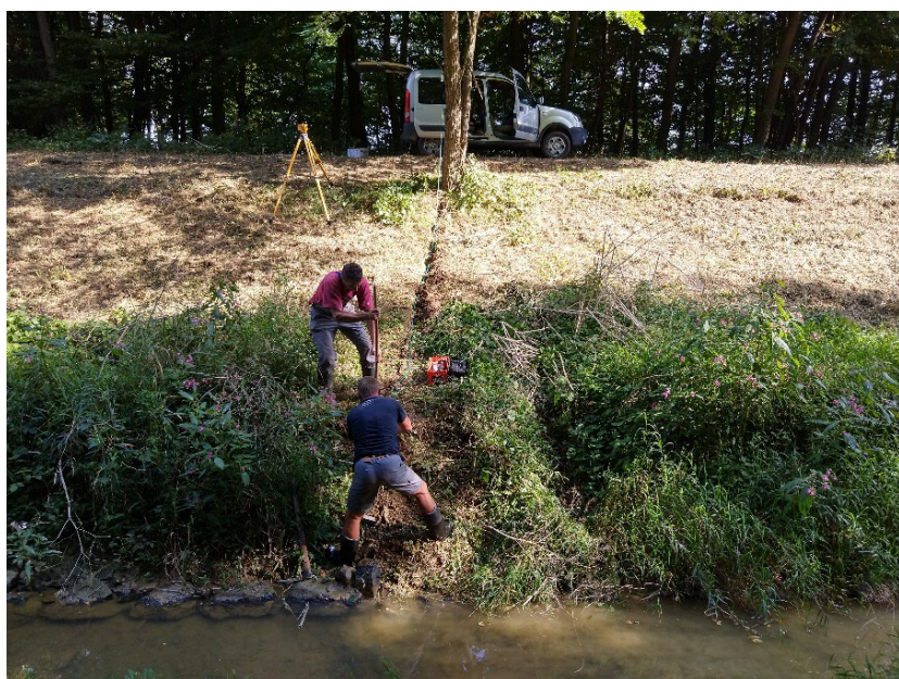
Slika 3: Vkop signalnega kabla v teren.
